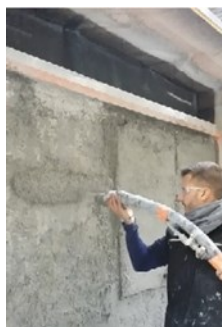
Détail du principe de projection en ITE - PAREXGroup 2017
