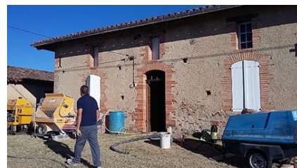
Isolation intérieure en enduit isolant au chanvre projeté. 10.2015
